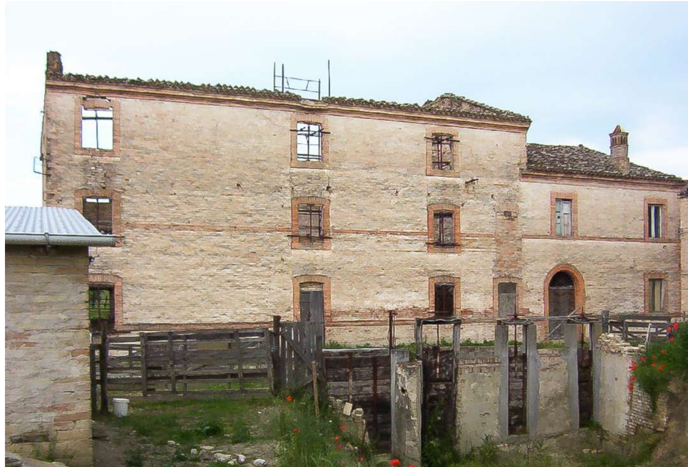
Fronte strada - Lato ovest foto scattata prima degli interventi di restauro
