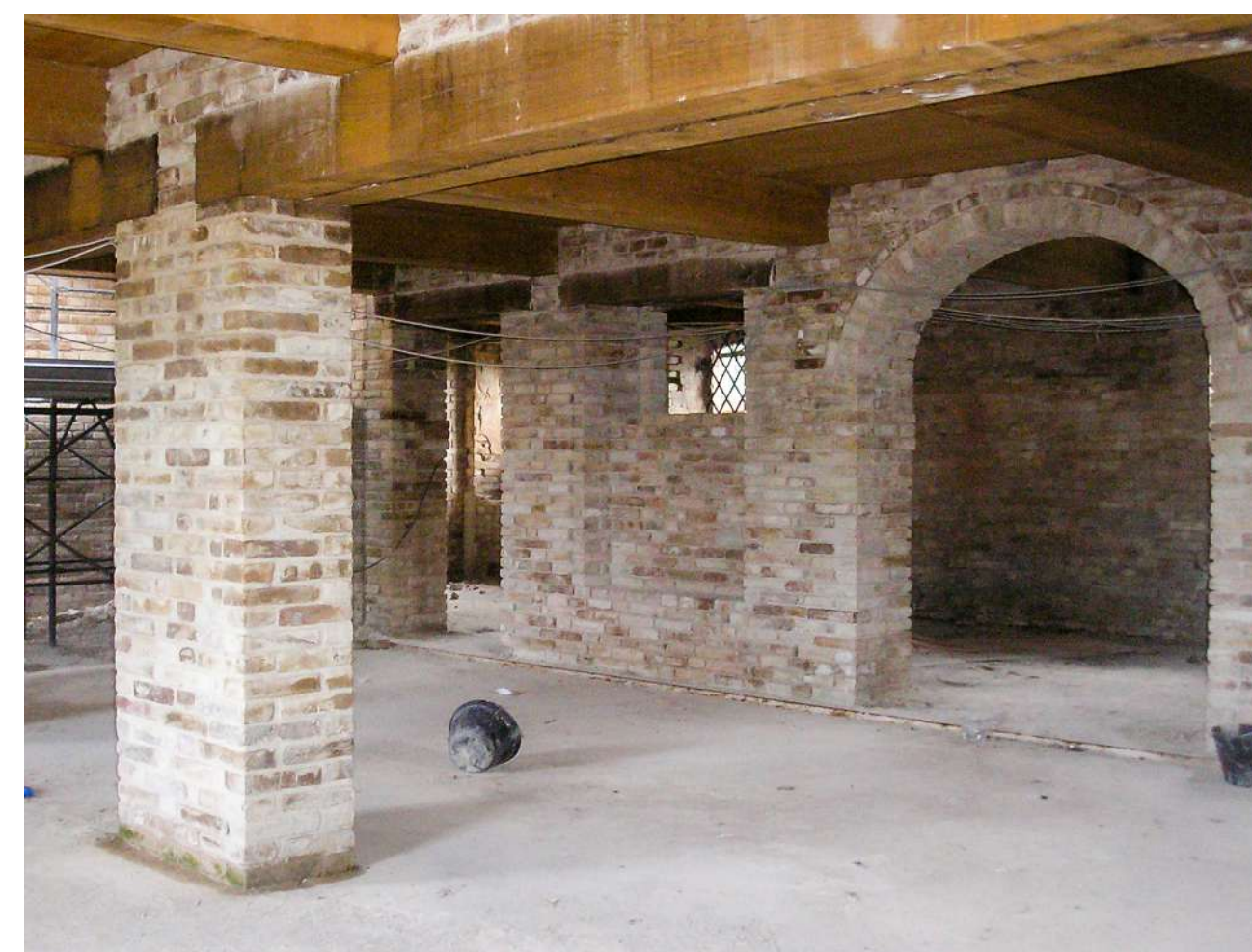
Interno del Mulino foto scattata durante gli interventi di restauro
