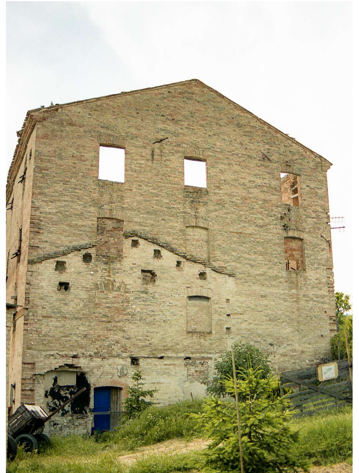
Fronte nord foto scattata prima degli interventi di restauro
