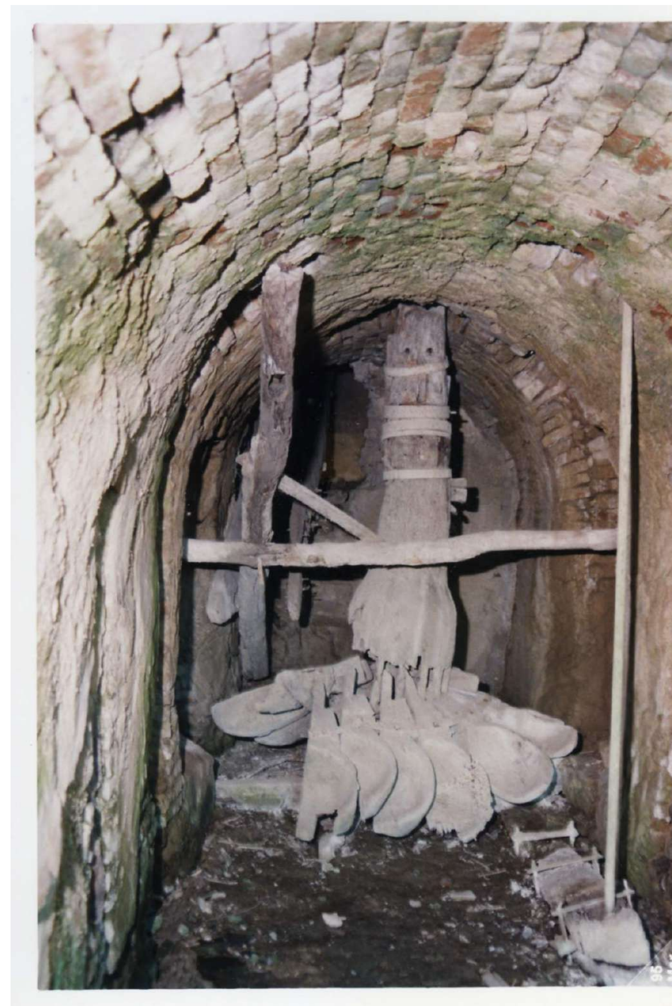
ritrecine del Terzo Mulino prima dello smontaggio per il restauro marzo 1995
