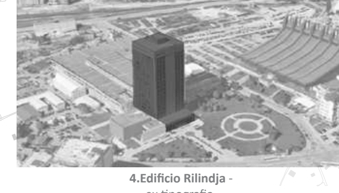
4. Edificio Rilindja - ex tipografia, ora la funzione è stata modificata
