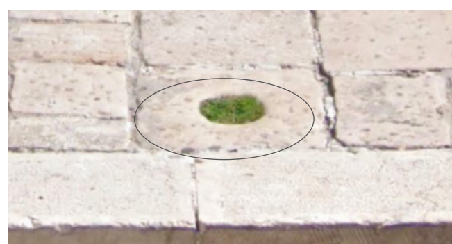
FORO ADIBITO ALL'INSERIMENTO DEI PALI PER LUMINARIE - ACQUAVIVA DELLE FONTI (BA)
