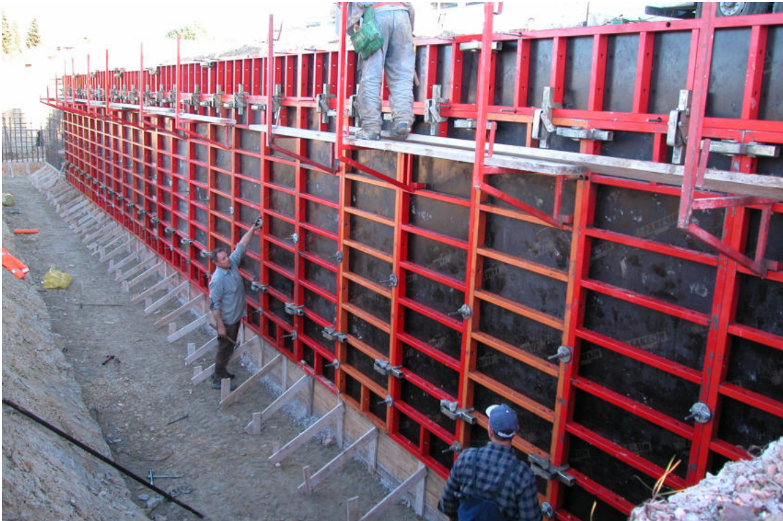
Cantiere allestito con casseformi Faresin fornite da Adriano Callarelli, Ancona 2019.
