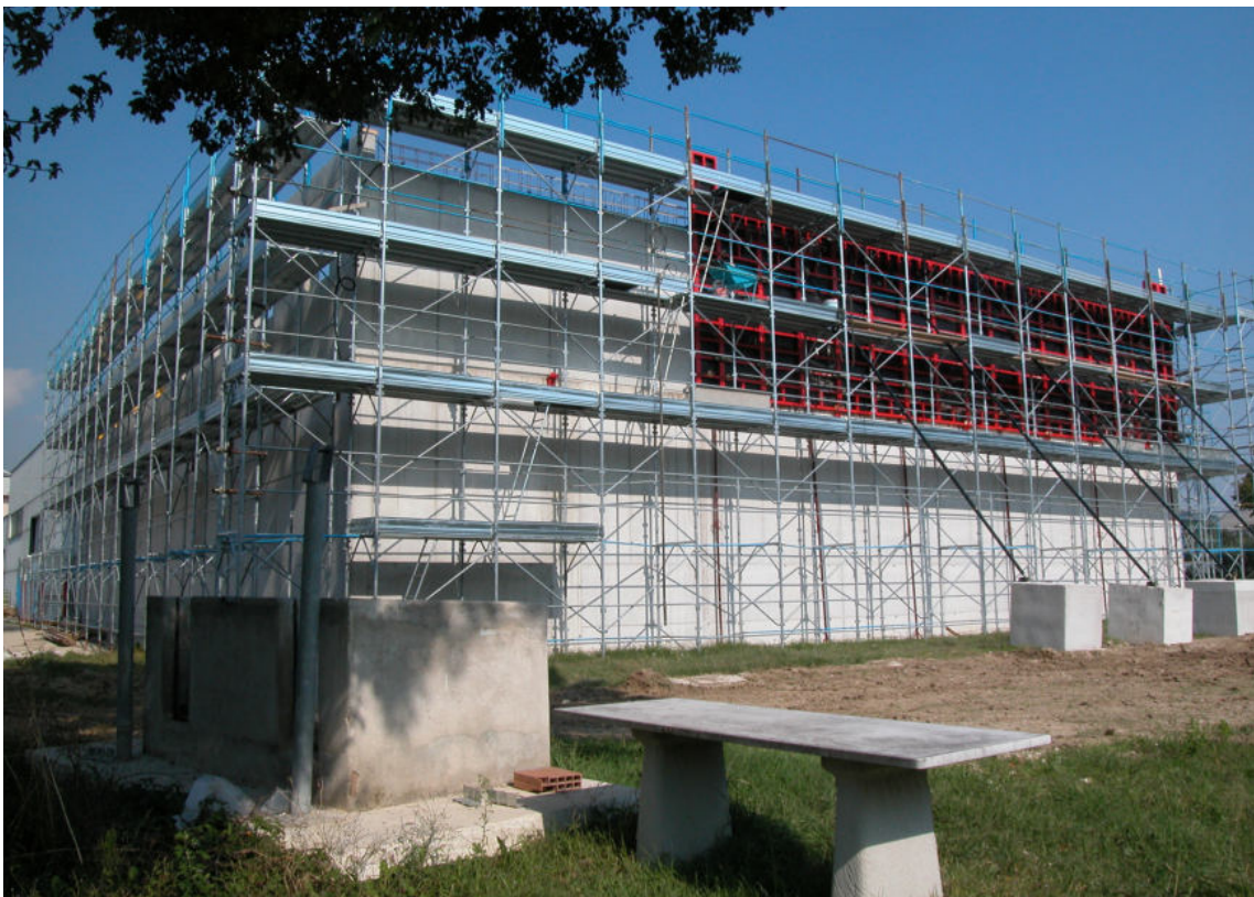
Lavori per ampliamento dell'attuale sede operativa.
