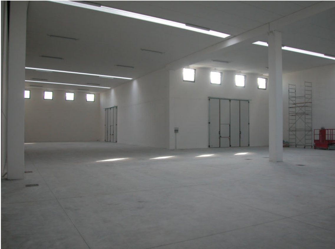
Lavori per ampliamento dell'attuale sede operativa.
