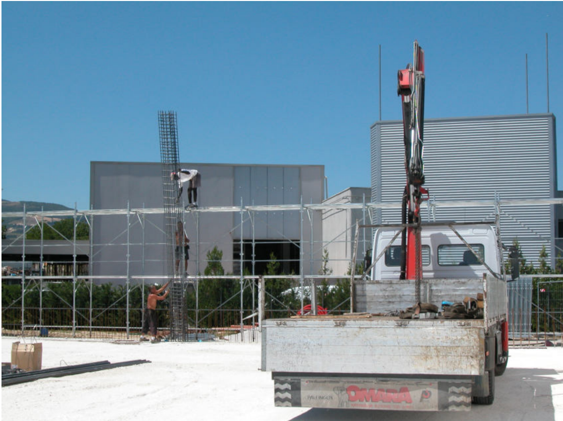
Lavori per ampliamento dell'attuale sede operativa.
