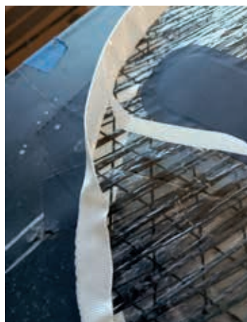
Applicazione della fettuccia in nylon lungo il bordo della sacca con nastro biadesivo-1.
