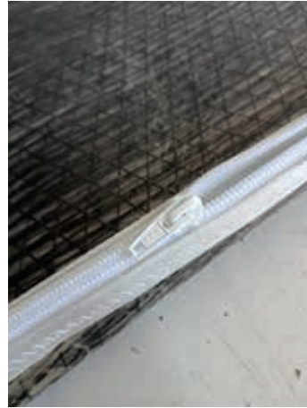
Dettaglio della cerniera cucita alla sacca.
