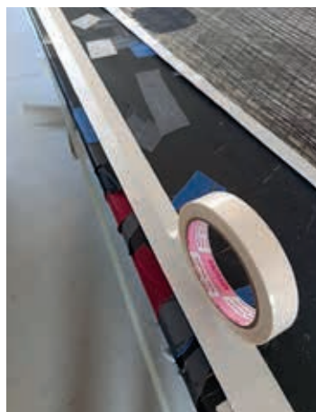
Applicazione del nastro biadesivo sulle fettucce in nylon.
